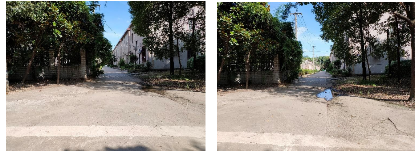
图 3.1-27 遥观镇芳庄村农村排水现状图
