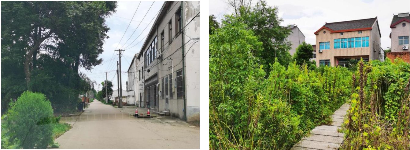
图 3.1-33 遥观镇新南村农村排水现状图
