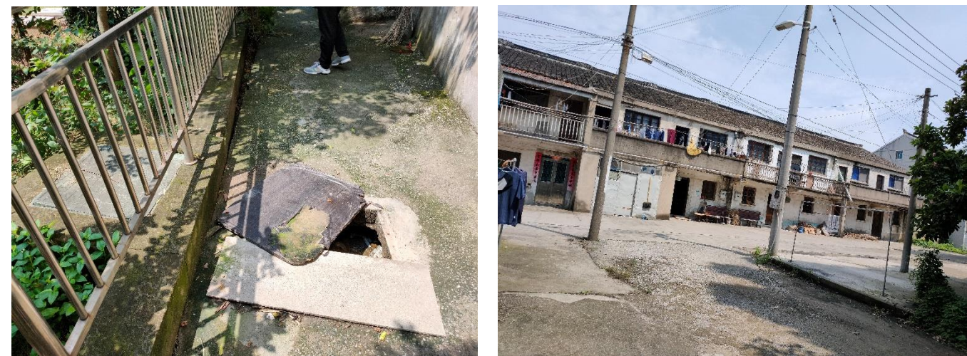
图 3.1-30 遥观镇留道村农村排水现状图
