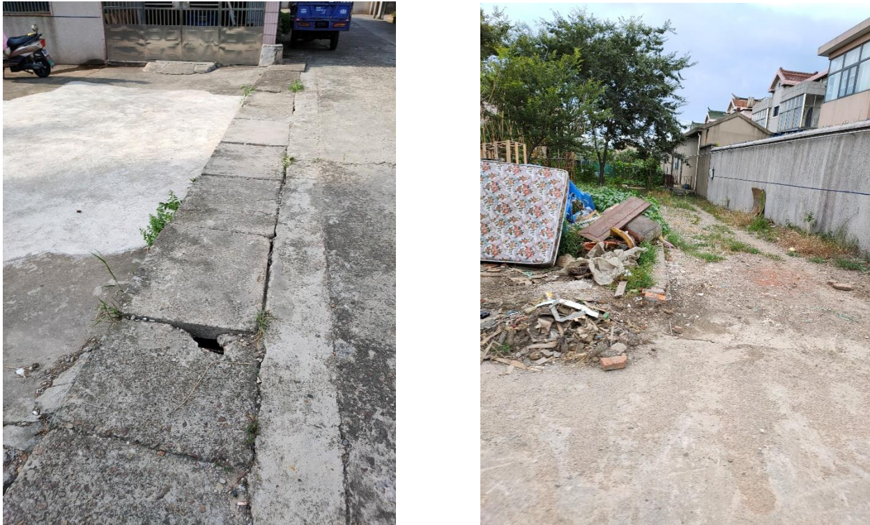
图 3.1-32 遥观镇前杨村农村排水现状图
