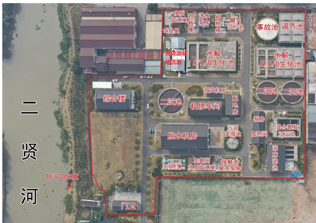
图 3.1-2 常州东方前杨污水综合处理有限公司鸟瞰图
