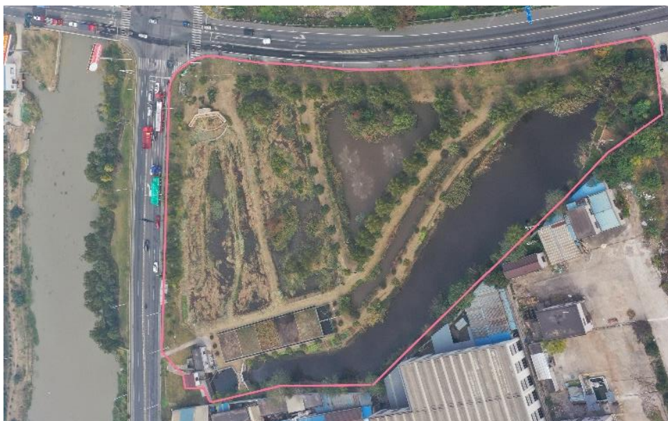
图 3.1-7 常州东方前杨污水综合处理有限公司尾水湿地现状
