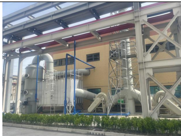
废气处理装置 (水喷淋+除雾+活性炭吸附装置)
