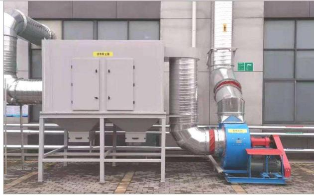
滤筒除尘器工程实例图
